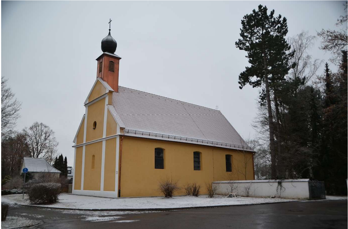
In neuem Glanz erstrahlt die Sebastianuskirche im Allersberger Friedhof. Im Außenbereich sind die Hüllen und das Gerüst bereits gefallen und bald wird auch die Innensanierung abgeschlossen sein und die Kirchentür wird wieder geöffnet für alle. Foto: Josef Sturm
